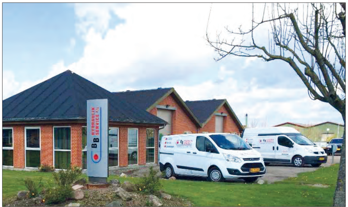
AVN og BB Hydraulik Services rammer på Handelsvej i Odense udvides nu markant.
